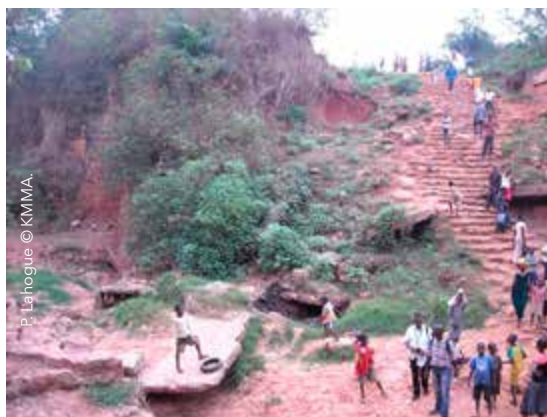
Uitgestrekte verzakte zone in Mbujimayi, waar de karst verborgen ligt onder een zandsteenachtige laag. De weg liep oorspronkelijk horizontaal vanaf de top van de trappen die werden aangelegd na de verzakking.
