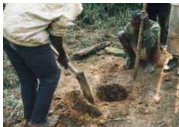
1. Creusage de l'emplacement du fourneau (1).
