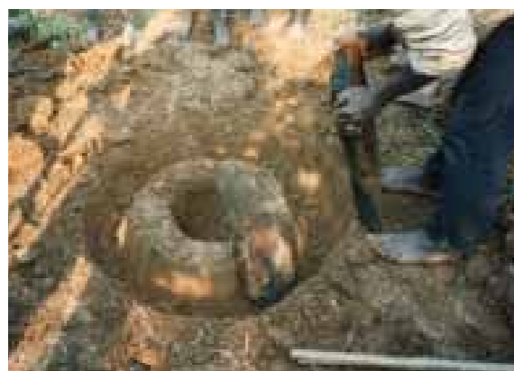
3. Pose des roches sur le pourtour du fourneau.
