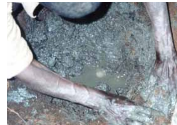
La cavité est enduite de l'argile dénommée « ngwa » ou « nambu ».
