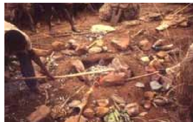
13. Poursuite du démontage du fourneau.
