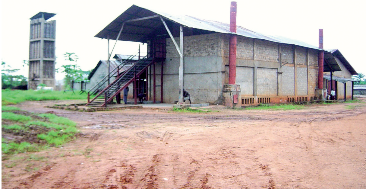
III. HT 21. Vue des installations du CDI-Bwamanda à Bwamanda. (Collection CDI-Bwamanda/Heverlee, 2004.)
