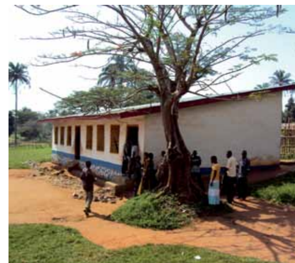
III. 20.2. Bâtiment de l'école primaire d'Elikyia en 2010.
