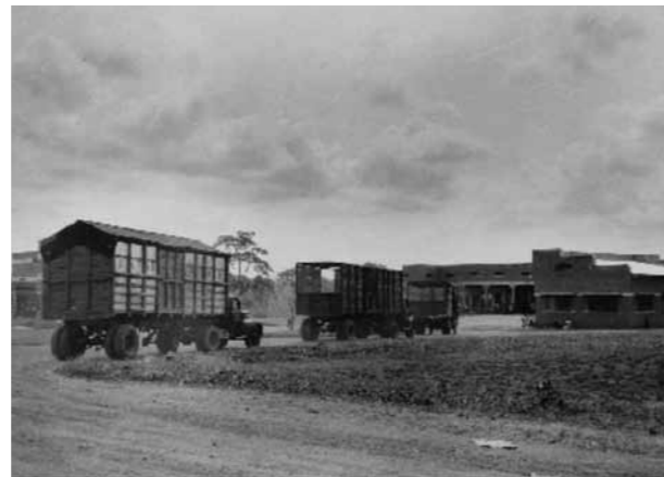
III. 14.3. Installation de la Société de transport à Gemena, 1951. (HP.1956.15.13874, collection MRAC Tervuren ; photo J. Mulders [Inforcongo], 1951, MRAC Tervuren ©.)
