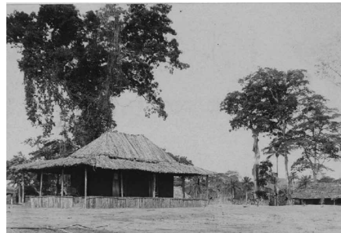
III. 13.8. Coin du poste à Dongo en 1913. (AP.0.0.12169, collection MRAC Tervuren ; photo A. Hutereau, 1913.)
