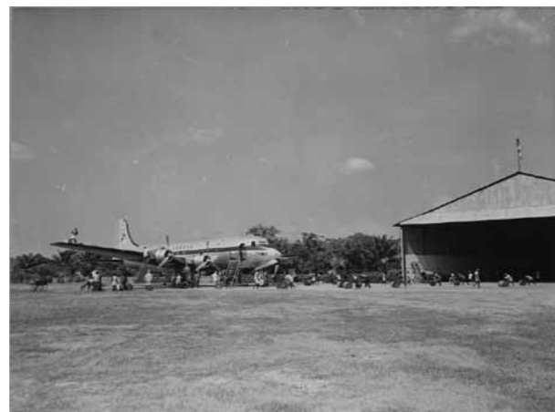
III. 14.11. Un aspect de l'aérodrome de Libenge, 1951. La piste d'envol, longue de 2200 m, est accessible aux avions internationaux. (HP.1956.15.13410, collection MRAC Tervuren ; photo J. Mulders [Inforcongo], 1951, MRAC Tervuren ©.)
